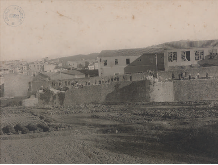
Fig. 12. Works of demolition of the wall of the Mercadal. 1901-1908, Fotografia Unal. Ajuntament de Girona - CRDI
