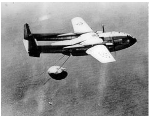
Εικόνα 2: Αεροσκάφη ανακτούν την κυψέλη που περιέχει το φωτογραφικό φιλμ από το δορυφόρο CORONA.
