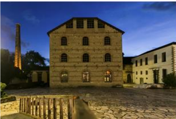
Εικ.1. Αποψη των κύριων κτισμάτων του συγκροτήματος του Μύλου Ματσόπουλου.
