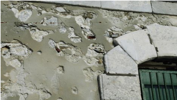
Εικόνα 5: Επιφανειακή διάβρωση λίθων, επιχρισμάτων (ρηγματώσεις, κυψελώδης διάβρωση)
