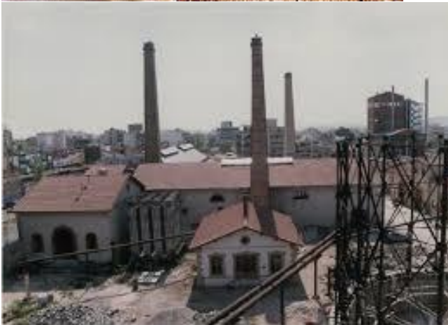
Εικόνα1, 2. Το Φωταέριο Αθηνών ως βιομηχανικό κτίριο νεότερης πολιτιστικής κληρονομιάς, πριν την επανάχρησή του.
