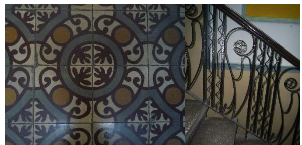
Εικ. 14,15: Λεπτομέρεια ταιμεντοπλακιδίου στα δάπεδα του κτιρίου και του κιγκλιδώματος των κεντρικών κλιμακοστασίων πρωτότυπο
