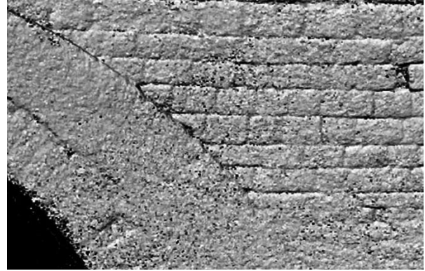
Εικόνα 6: Λεπτομέρεια της πέτρινης τοιχοποιίας όπως αποτυπώθηκε στο πυκνό νέφος σημείων υψηλής ανάλυσης
