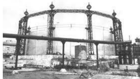
Εικόνα 3, 4. Μηχανολογικός εξοπλισμός του Φωταερίου Αθηνών, πριν την επανάχρησή του
