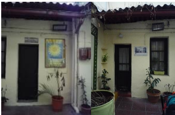
Εικ.10: Άποψη των ισόγειων βοηθητικών προσκτισμάτων στον ακάλυπτο χώρο του οικοπέδου. Πρωτότυπο
